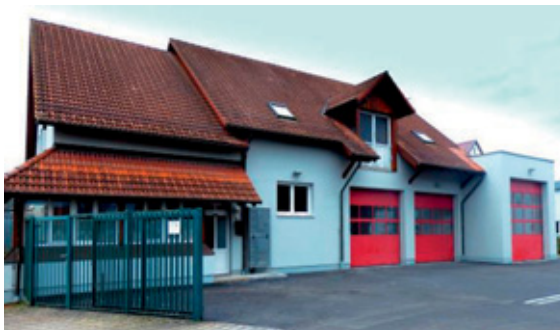
Ehemaliger Bauhof, jetzt Feuerwehrhaus mit drei Stellplätzen
