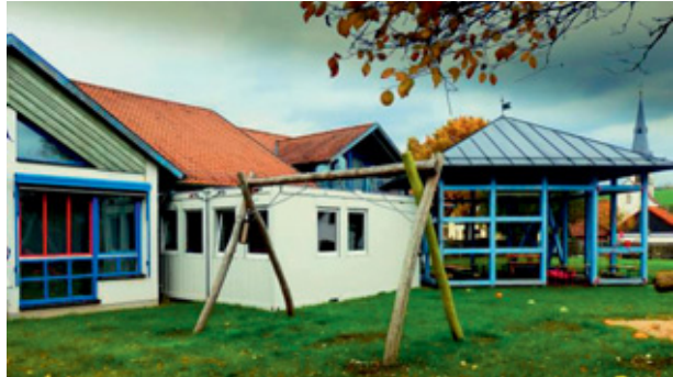
Bis zur Fertigstellung des Anbaus steht ein Containeranbau im Garten zur Verfügung.
