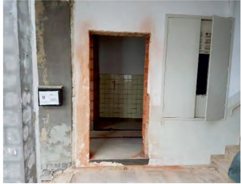
**Bild rechts, unten:** Die Trennwand im unteren WC wurde entfernt. Hier entsteht das barrierefreie WC mit einem Zugang von der Hofseite und einem Zugang vom inneren des Gebäudes.
