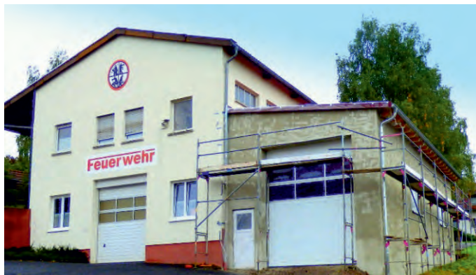
Fast fertig. Der Anbau an das Feuerwehrhaus in Windshausen.
