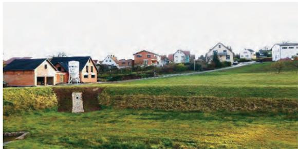
*Neue Zuführung des Oberflächenwassers in das Rückhaltebecken im Erdmannstal. Diese Maßnahme entlastet die Abwasserkanäle im Ortsbereich*
