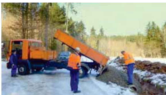
Einbau einer Überfahrt im Bereich des Waldspielplatzes Kalter Rasen durch die Bauhofgemeinschaft.
