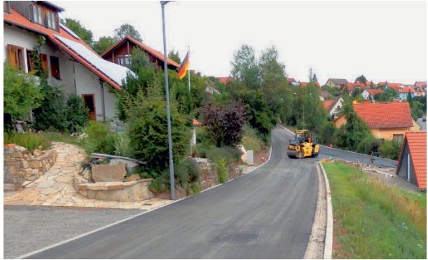
Wie geplant konnte noch vor der urlaubsbedingten Unterbrechung der Bauarbeiten die Feindecke aufgebracht werden.
