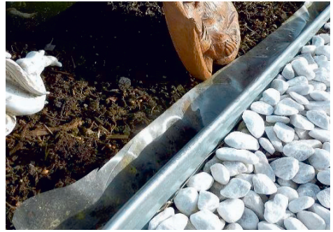
Geht auch nicht mehr. Folienabdeckung unter einer Kiesschüttung.
