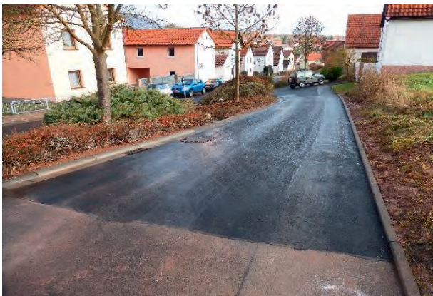
Neue Asphaltdecke in der Langen Eller in Windshausen
