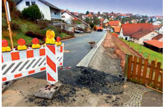
Die Böschungssanierung ist abgeschlossen, die Asphaltdecke bereits eingebaut.
